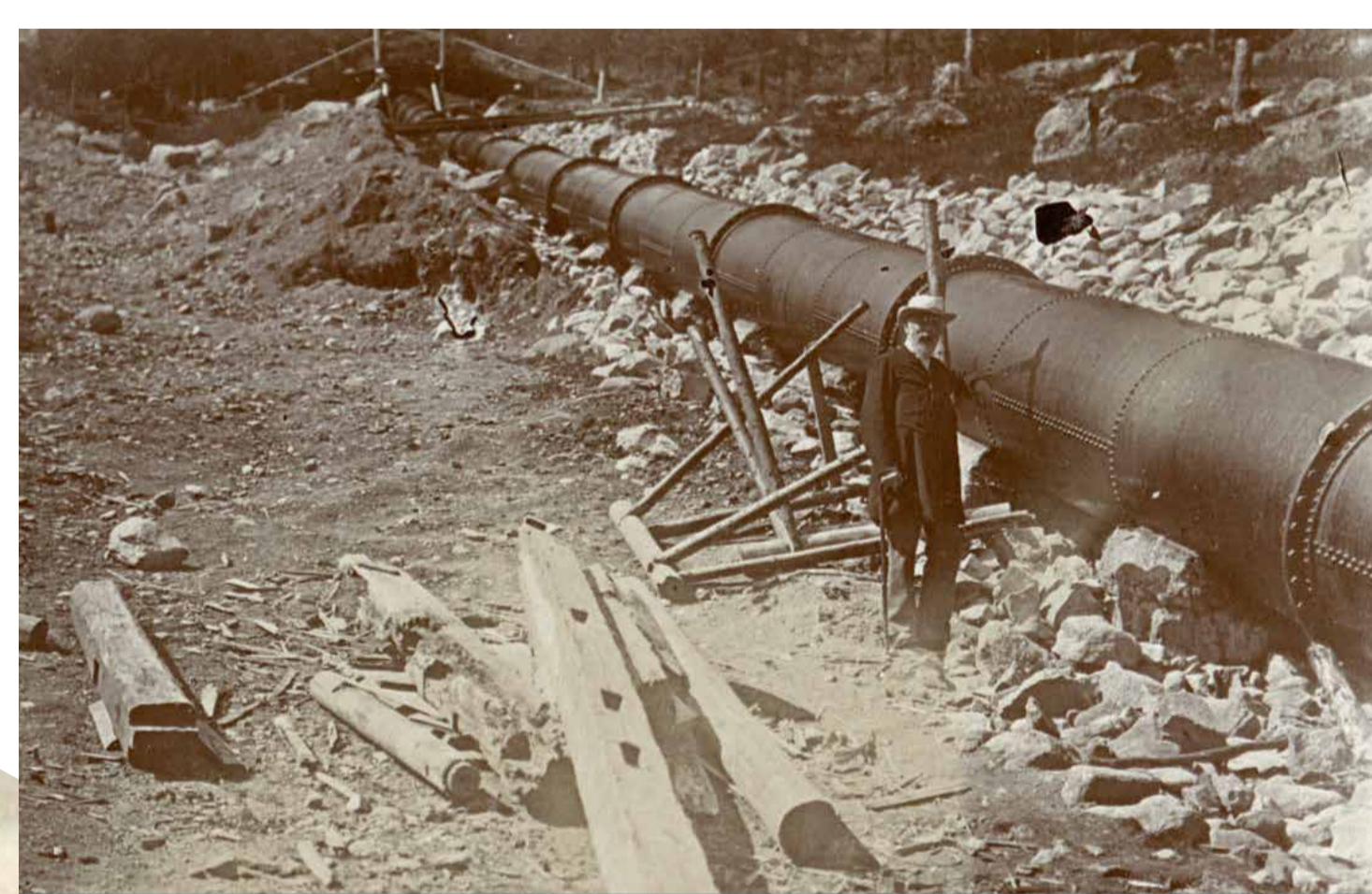
Władysław Folkierski (1841-1904) – inżynier, profesor uniwersytetu w Limie, zaangażowany w budowę kolei Chabówka-Zakopane, wodociągu fabrycznego w Kuźnicach oraz regulację potoku Bysire. Stoi przy nowej rurze żelaznej kuźnickiego wodociągu.
