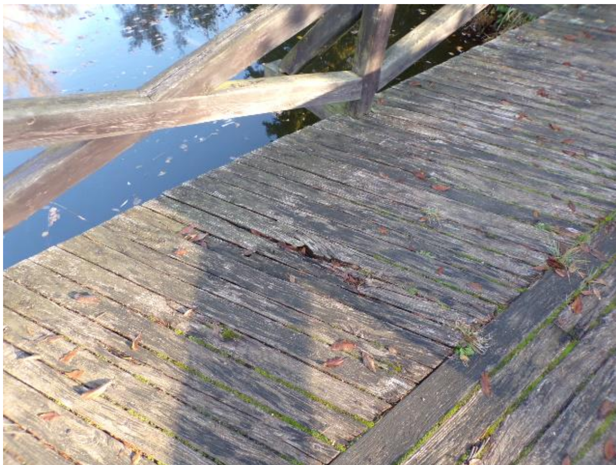
Widok na most – przęsła i pomost
