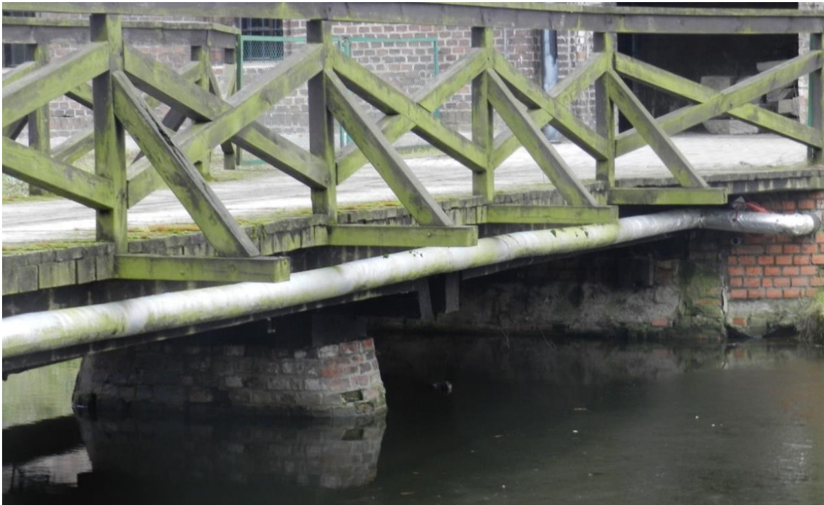
Widok na pomost, filar i przyczółek w kierunku do zamku
