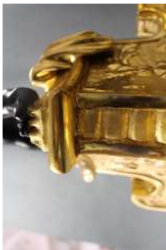
Fot. 20. Gerydon MK 2889, rozległe pęknięcie pod górnym gzymsem podstawy.
